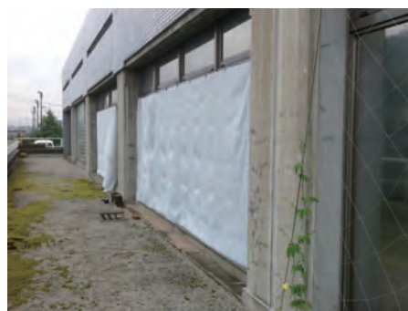
本部西側窓に遮蔽カーテンを設置
